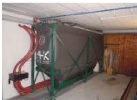
Trogsilo mit mehreren Saugentnahmepunkten
