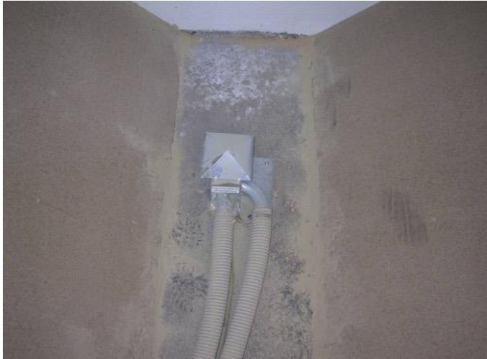
Schrägboden bis zum Boden -FALSCH
